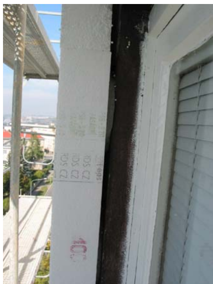
Obr.19 Nezatepované okenní ostění
